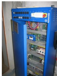
Steuerung-Lift
